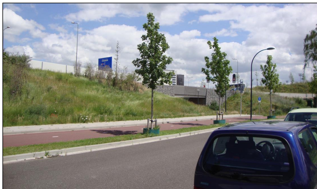
De Kolonel Millerstraat, het tweezijdig fietspad en de hoger gelegen Viaductweg
